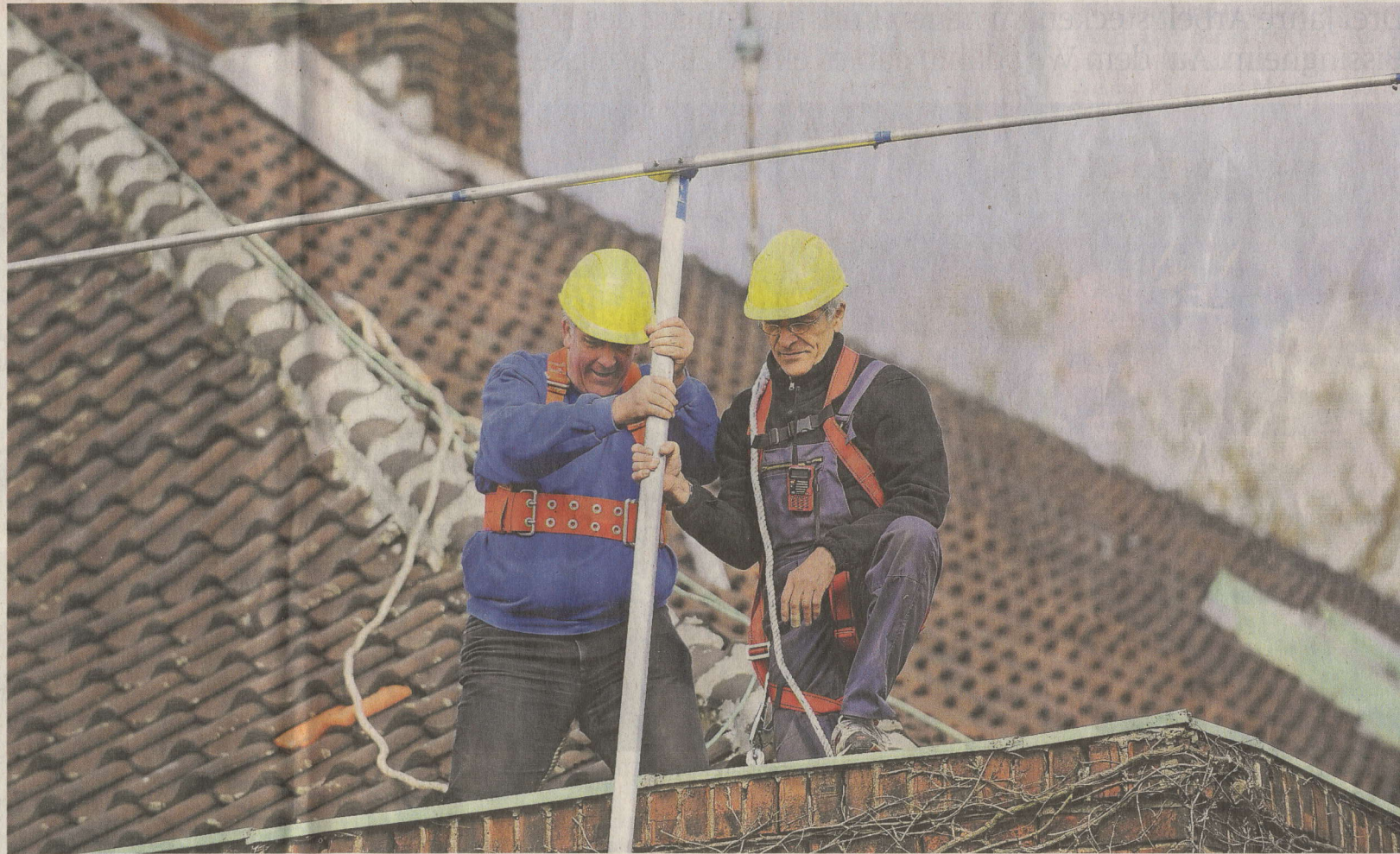
Benno Jacobs und Horst Indek (von links) montieren die brandneue Antenne auf dem Dach.
